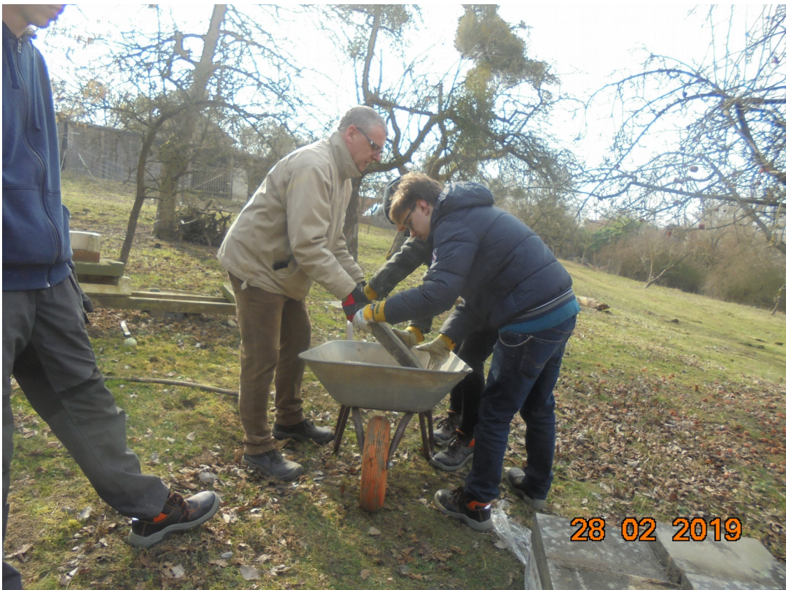
... brachten die Platten in das Bienenhaus ...
