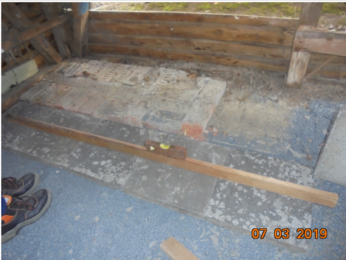
... und verlegten sie. Hier die erste (halbe) Reihe.
